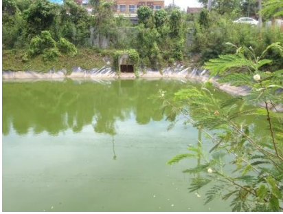
รูปที่ 3.2-7 ระบบปรับปรุงคุณภาพน้ำที่ 1 (สถานีที่ 1/1) ปิดระบบเนื่องจากเครื่องเติมอากาศและแผ่น HDPE ชำรุด
