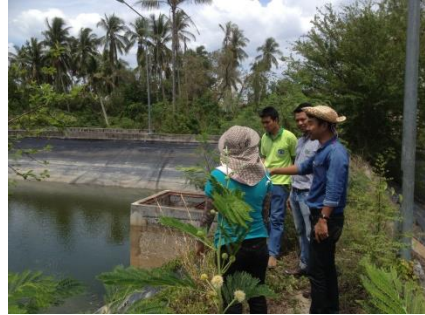
รูปที่ 3.2-7 ระบบปรับปรุงคุณภาพน้ำที่ 1 (สถานีที่ 1/1) ปิดระบบเนื่องจากเครื่องเติมอากาศและแผ่น HDPE ชำรุด
