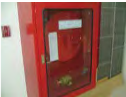
รูปที่ 21 การจับเตรียมอุปกรณ์ดับเพลิงเบื้องต้น
