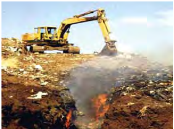
รูปที่ 26 การขุดหลุมและปิดทับด้วยดิน
