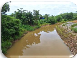
NWC2 สะพานบ้านหัวทิง 15 ส.ค.66
