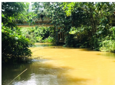
UT01 สะพานหลังวัดห้วยคู 8 สิงหาคม 2565
