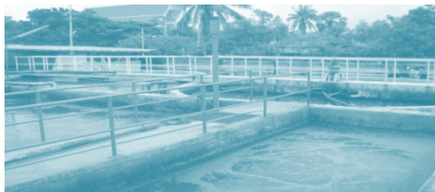
ภาพที่ ๔ ถังเติมอากาศระบบแอกติเวทเต็ดสลัดจ์
